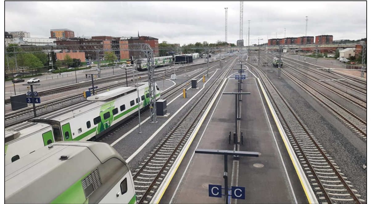
Turun rautatieasema. Kuva: Minna Sirkiä, WSP Finland Oy.
