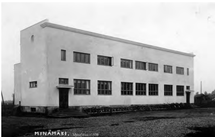
Työväentalosta vuonna 1935 remontoitu suojeluskuntatalo. Kuva: Wirmo-seuran kokoelmat.
