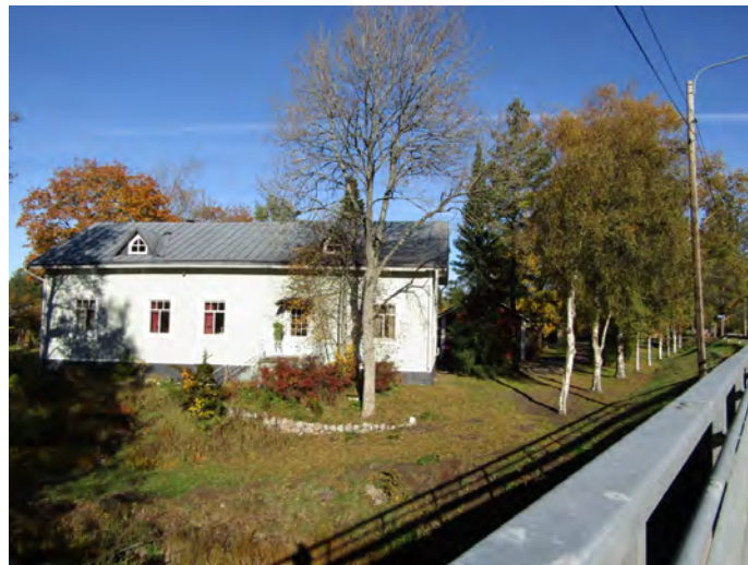
Hemmilän päärakennus, joka on toiminut kappalaisen pappilana vuoteen 1959, on rakennettu noin 1890. Kuva: Paula Saarento/TMK.
