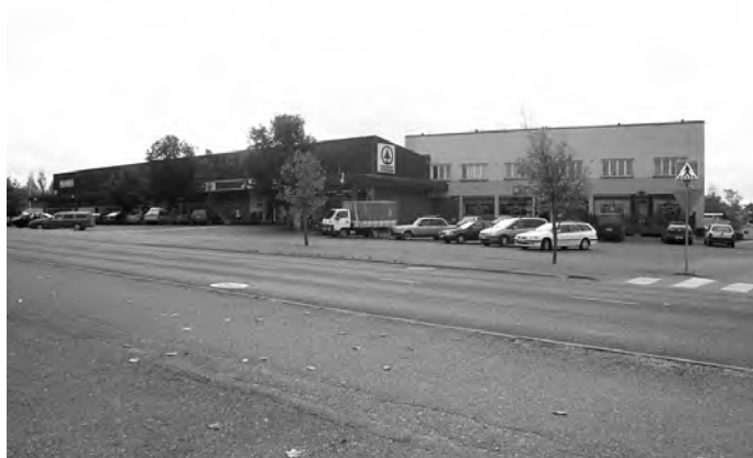
Osuuskaupan rakennus laajennuksineen. Kuva: Jaakko Liuke/TMK.
