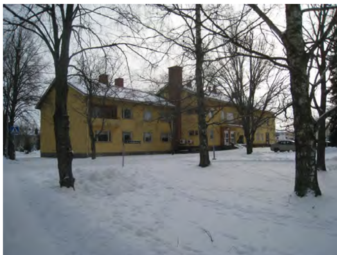
Maaseudun keskusrakennustoimiston suunnittelema kunnantalo 1954. Kuva: Eija Suna/TMK.
