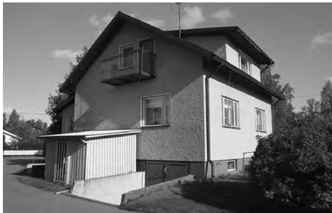
Vuonna 1955 valmistunut rintamamiestalo, jonka ulkoasu on säilynyt katetta lukuun ottamatta alkuperäisenä (Veikkola/Pappila). Kuva: Jaakko Liuke/TMK.
