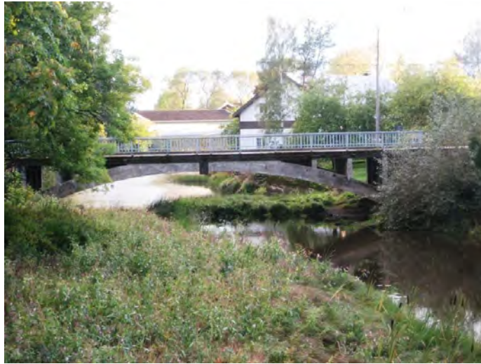
1970-luvun korjauksessa Mäenkylän silta sai teräskaitteet ja betonikannen. Kuva: Anna-Liisa Nisu.
