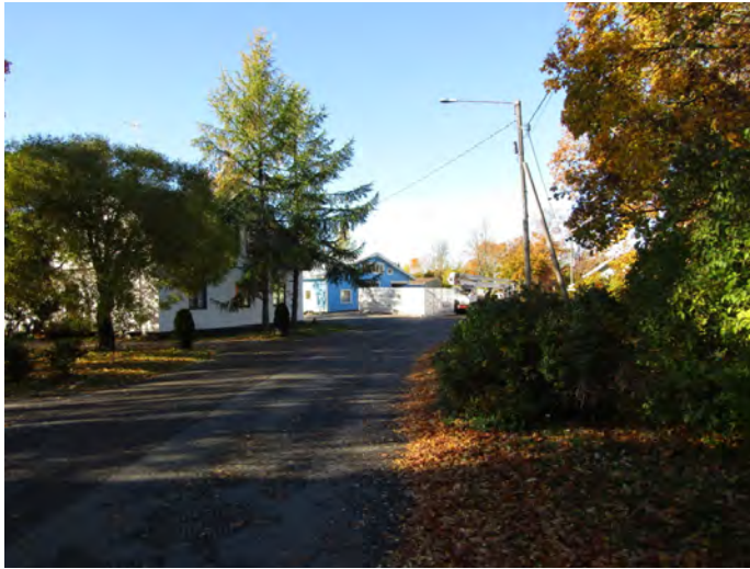
Nihattulantieltä pohjoiseen, vasemmalla Häävuorentien kulmassa oleva rakennus on 1920-luvulla rakennettu verstaas (Ahjola). Sen eteläpuolella oleva rakennus on rakennettu 1929, ja siinä on toiminut Osuuskauppa Apajan sivukauppa. Kuva: Paula Saarento/TMK.
