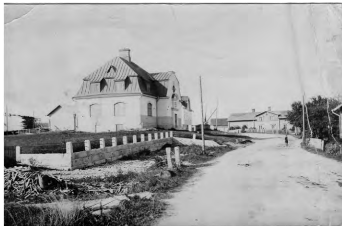
Säästöpankin rakennus. Kuva: Wirmo-seuran kokoelmat.
