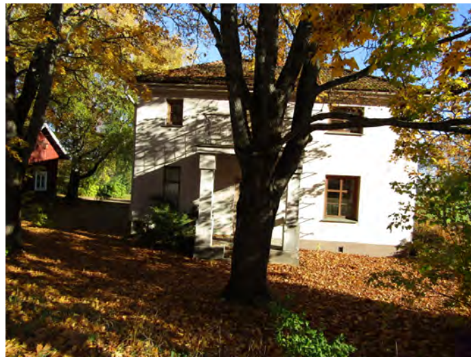
Aumakattoinen tiilirunkoinen rapattu kaksikerroksinen asuintalo 1936–1937, jossa on vaikutteita klassismista (Hietarinta/Nihattula). Kuva: Paula SaarentoTMK.
