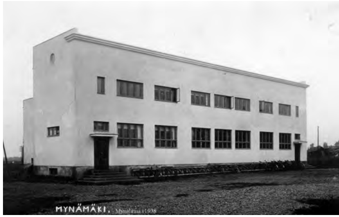
Työväentalosta (1911) remontoitu suojeluskuntatalo 1935. Kuva: Wirmo-seuran kokoelmat.
