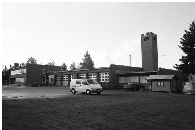
Maanviljelysseuran arkkitehtitoimiston suunnittelema punatiilinen paloasema 1968. Kuva: Jaakko Liuke/TMK.
