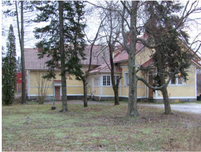
Nahkatehtaan johtajan asuinrakennus ja konttori, rakennettu 1910. Kuva: Paula Saarento/TMK.
