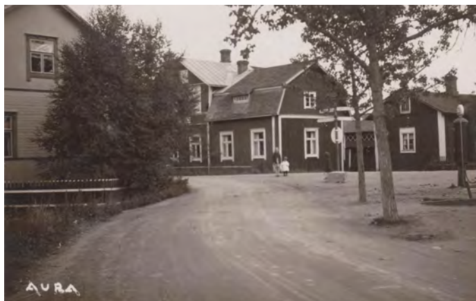
Majatalo Ali-Knaapin rakennuksessa vanhalla kylätontilla. Rakennus purettiin 1970-luvulla. Kuva: Auran kotiseutuyhdistyksen kokoelmat.
