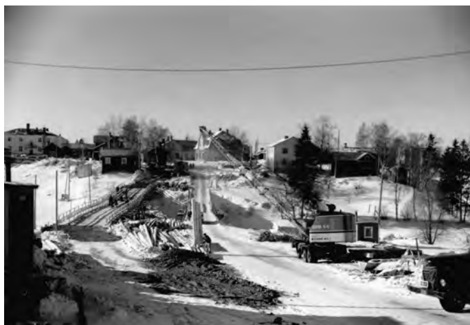
Tarvasjoentien uutta siltaa rakennetaan 1963. Kuva: Auran kotiseutuyhdistyksen kokoelmat.
