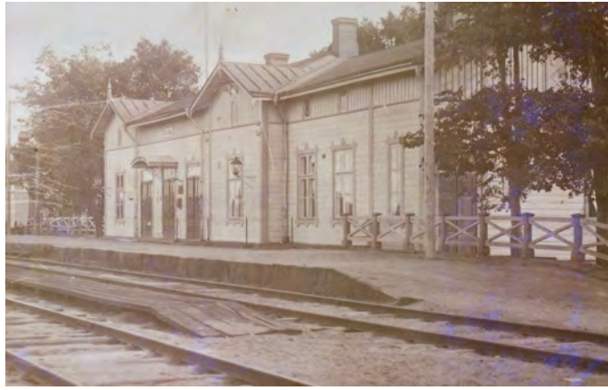
Auran rautatieasema rakennettiin 1875–1876 Knut Nylanderin tyyppiirustuksen mukaisesti IV luokan asemarakennukseksi. Rakennusta laajennettiin ja siihen tehtiin muutoksia 1908–1909 B. Granholmin toimiessa suunnittelijana. Kuva: Auran kotiseutuyhdistyksen kokoelmat
