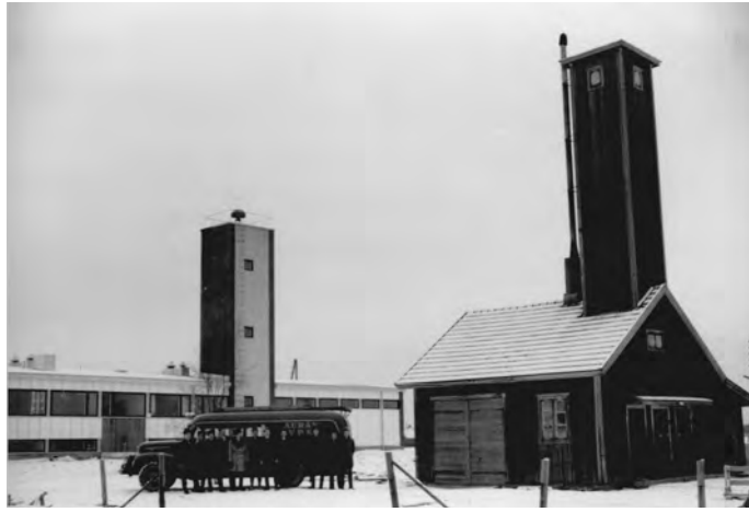
Vanha ja uusi paloasema. Uusi rakennettiin 1960–1962 ja vanha purettiin 1960–1970-luvun vaihteessa. Kuva: Auran kotiseutuyhdistyksen kokoelmat.
