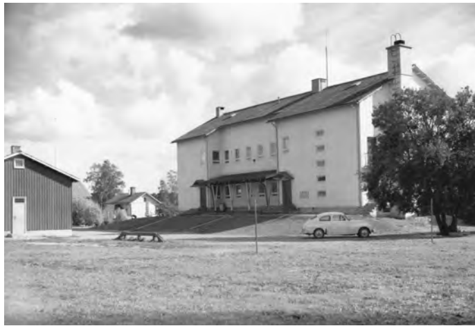
Matti Vaiston suunnittelema koulurakennus "Kivikoulu" valmistui 1952. Kuva: Auran kotiseutuyhdistyksen kokoelmat.
