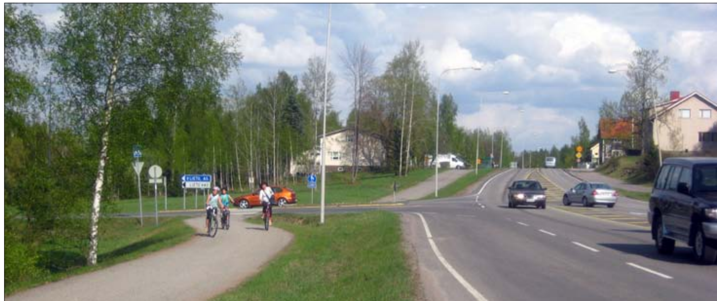
Kuva 4. Valtatie 10 ei täytä valtatieverkolle asetettuja vaatimuksia Liedon kohdalla.
