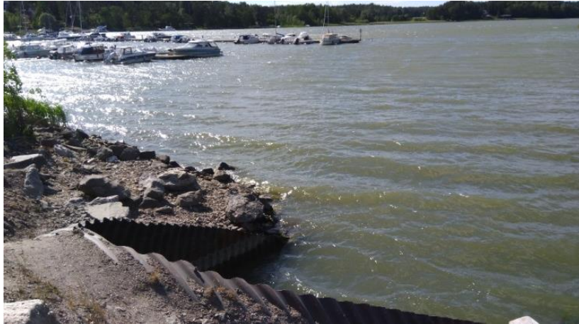
Kuva 19. Sillan aukko on nykyisiä pengertien rumpuja leveämpi, joten siltaratkaisu parantaisi veden virtausta ja vaihtelua lähisalmissa.
