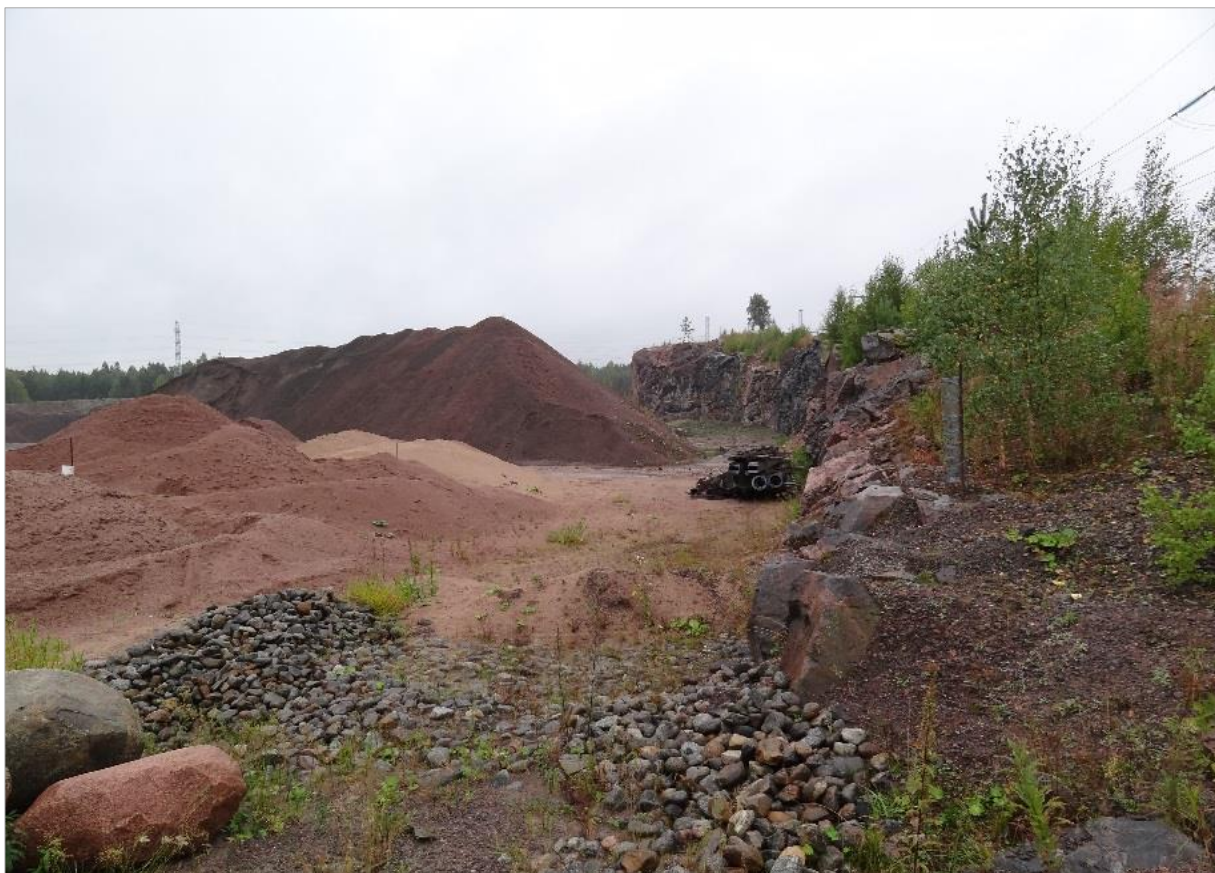
Kuva 33. Luolalan kallion murskausasema rajoittuu lunastettuun voimajohtoalueeseen.
