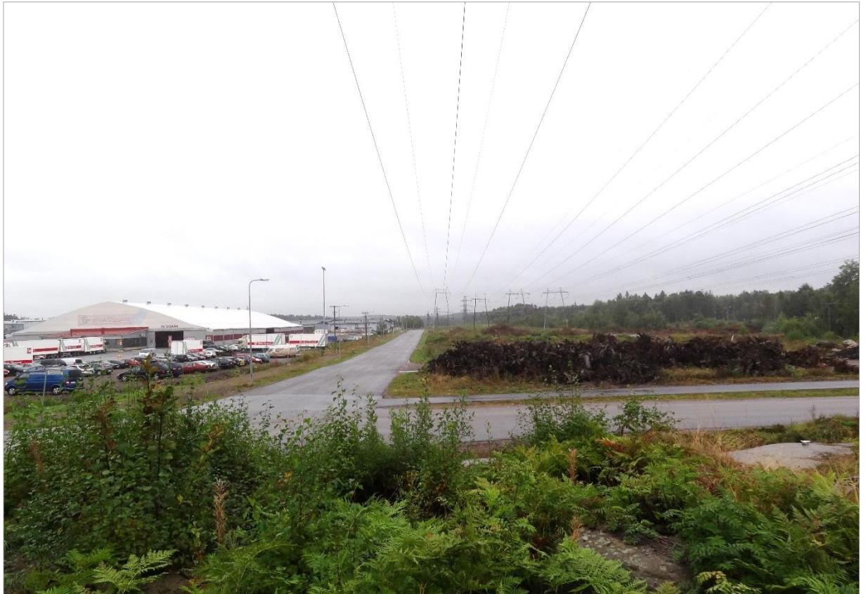
Kuva 15. Luolalan alueella, lähellä uutta Naantalinsalmen sähköasemaa useita 110 kilovoltin voimajohtoa sijoittuu rinnakkain samalle johtokadulle.
