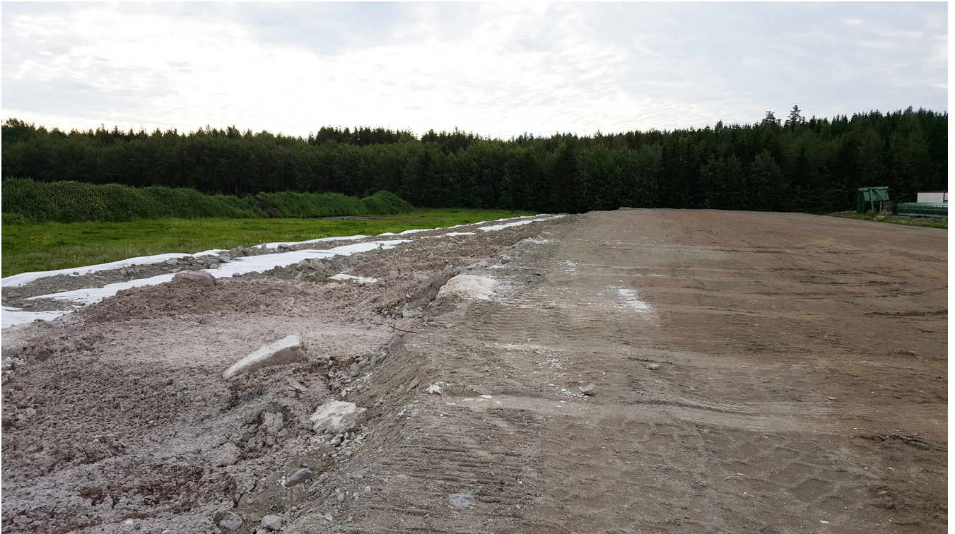
KUVA 1: Lounais-Suomen Hakelämmön kenttäratkaisu Turun Saramäessä toteutettiin maarakentamisen uusiomateriaaleja (kivihiilen polton tuhkaa, betonimursketta) hyödyntäen.
