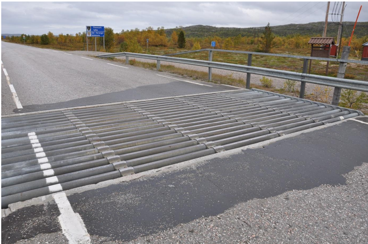
Kuva 35. Kuolpunan poroestesilta Inarissa (kuva Jouko Karjalainen, Lapin ELY-keskus).
