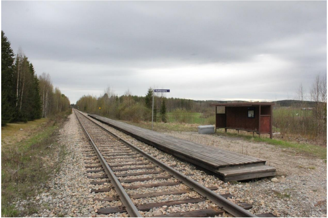
Kuva 6. Kohtavaaran seisake edustaa perinteistä paikallisjunaliikenteen pysähdyspaikkaa. Pysähdyspaikan varustelu on pysynyt vuosikymmeniä lähes muuttumattomana eikä tiedossa ole mainittavia parannuksia. Puulaiturin pituus on 56 m. Kohtavaara, 16.5.2015. Kuva: Aarne Alameri.
