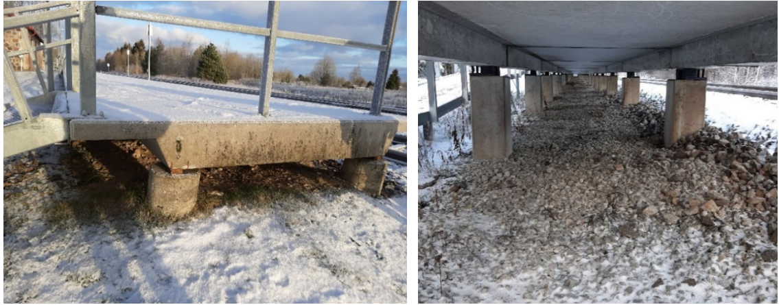
Kuva 15. Betonisen laiturin toteutustapa Viron rautateillä. Kuvat: Maunu Tast.
