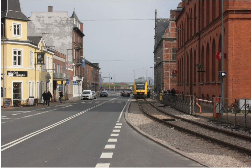
Kuva 27. Eräs katutilan toteutusmahdollisuus, jossa on huomioitu tila paikallisraide liikenteelle. Vastaava ratkaisu voidaan toteuttaa Tuulensuunkadun ja Naantalin ratapiha-alueen väliselle alueelle siinäkin tilanteessa, että osa nykyisestä rautatiealueesta muutetaan kaduksi. Helsingør, Jernbanevej, 23.3.2019. Kuva: Arne Alameri.
