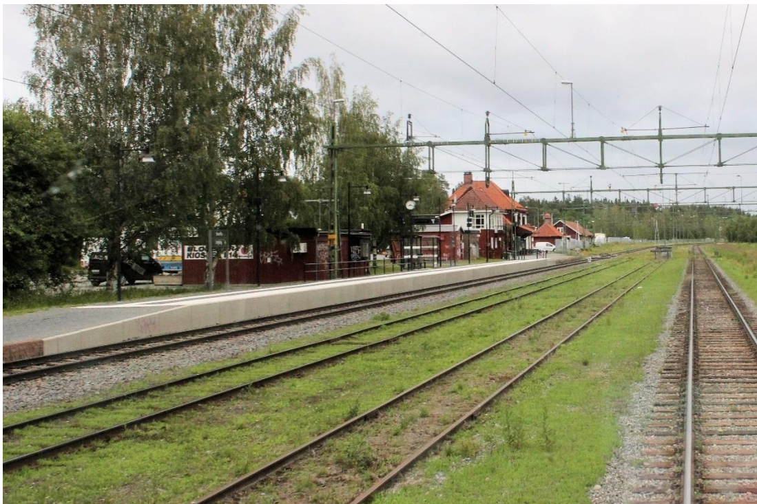
Kuva 11. Ången ja Östersundin välisellä rataosalla sijaitseva Brunflo asema, jolla laiturin on toteutettu osittain korkeana. Muutaman vaunun mittainen korotettu osuus varmistaa esteettömän yhteyden junien palveluvaunuihin. Pitkissä junissa osa vaunuista pysähtyy matalalle laiturin osalle. Brunflo, 7.7.2019. Kuva: Aarne Alameri.
