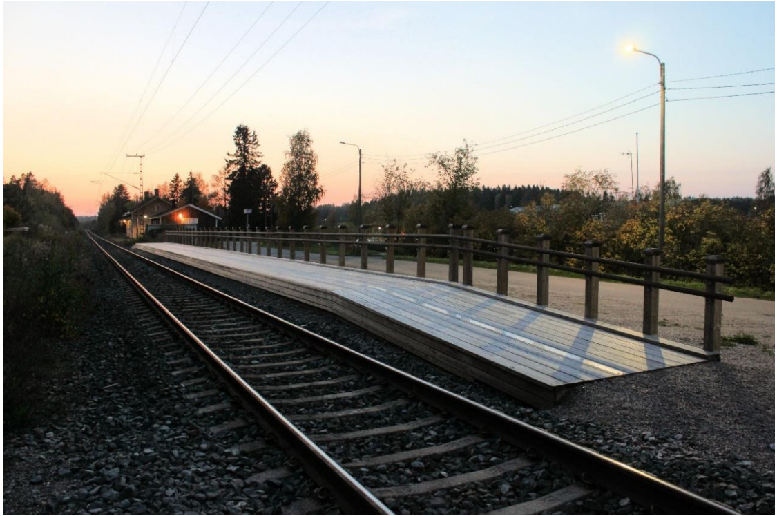
Kuva 4. Alueellisen junaliikenteen kevytrakenteisen seisakelaiturin toteuttamista kokeiltiin Sipoon Nikkilässä puurakenteisella 45 m pituisella koelaiturilla. Laituriratkaisulla selvitettiin puurakenteisen laiturin rakentamisen toimintatapoja ja kustannuksia, kokeilu liittyi myös valtion puurakentamishjelmaan. Laiturin korkeudeksi valittiin 40 cm, sillä se on lähellä duoraitiovaunujen tavanomaista laiturikorkeutta ja soveltuu myös rataosan museoliikenteessä käytetyn Dm7-kaluston astinlautojen korkeudelle. Nikkilä, 27.9.2020. Kuva: Aarne Alameri.
