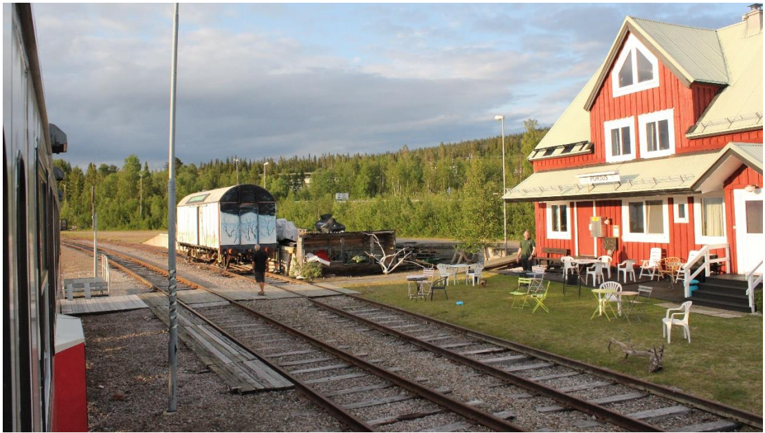
Kuva 24. Porjuksen asema on Ruotsissa Inlandsbanalla Arvidsjaurin ja Gällivaren välisellä rataosalla. Liikennepaikan pääraide sijaitsee kauimpana asemasta, joten laiturin sijaitseminen ratapihalle raiteiden väliin ja asemalta laiturille johtaa laituripolku. Laituri on suunniteltu yhden oven mittaiseksi ollen vain noin kahden metrin mittainen. Ritiä rakenteiselle laiturille on portaat sekä lastenvaunuramppi. Moottorivaunun etupää on juuri pysähtymässä laiturin kohdalle. Porjus, 11.7.2019. Kuva: Aarne Alameri.
