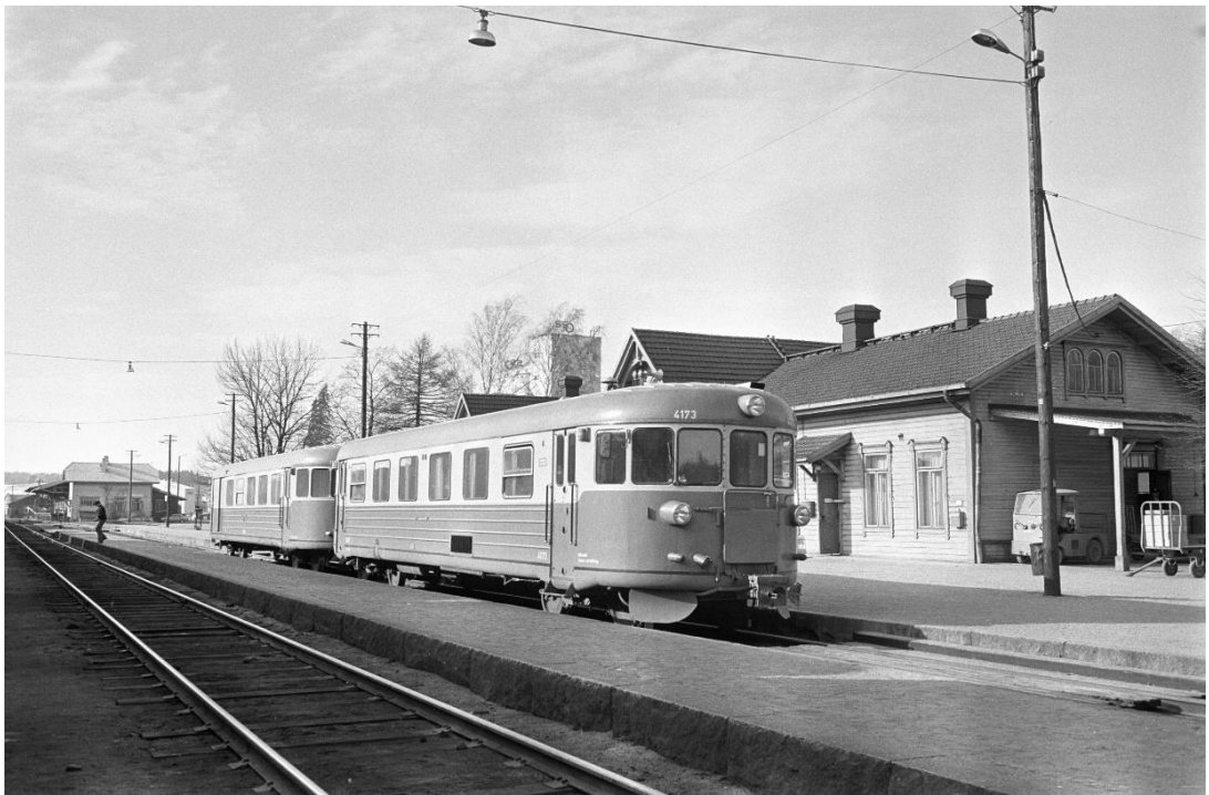
Kuva 8. Paikallisjuna pysähtyneenä Salon asemalla. Raiteiden 1 ja 2 väliin oli toteutettu välilaituri, jolle on yhteys laituripolun kautta. Molemmat laiturit ovat paasikivireunaisia ja hiekkapintaisia. Välilaiturilla ei ole kiinteitä rakenteita, vaan esimerkiksi valaistus on järjestetty ratapihan ylittävällä vaijeriripustuksella. Salo, 29.4.1971. Kuva: Tapio Keränen.
