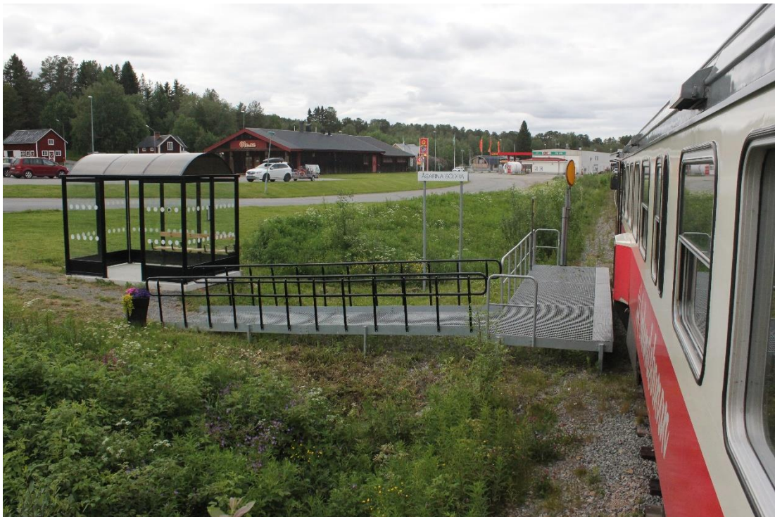
Kuva 21. Åsarna Södran seisake Ruotsissa Inlandsbanalla Moran ja Brunflon välisellä rataosalla. Esteetön ritilärakenteinen laiturin on 7,2 m pituinen. Laiturille johtava ramppi on suurin piirtein saman mittainen. Laiturin reunassa on kontrastireuna sekä kaiteet eri sivuilla. Seisakkeelle johtavan rampin vieressä on tavanomainen betonilaatalle perustettu bussipysäkkikatos. Y1 moottorivaunuja käytettäessä vaunun toinen ovi pysähtyy laiturin kohdalle tai kahden vaunun liikenteessä yksikköjen keskimäiset ovet. Seisakkeen toteuttamiskustannukset ovat olleet hyvin huokeat. Laiturielementtien kokonaishinta oli 75.000 SEK sekä pysäkkikatoksen 75.000 SEK. Laiturin asennuskustannus oli 50.000 SEK sekä pysäkkikatoksen 25.000 SEK. Kokonaiskustannus oli yhteensä suunnittelu huomioiden noin 225.000–250.000 SEK [Portinson 2020] eli noin 22.080–24.540 euroa maaliskuun 2021 valuuttakurssilla.
