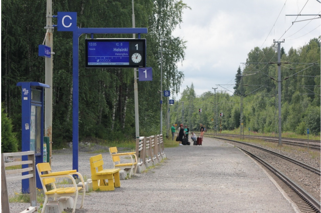
Kuva 8. Rautatieasemilla käytetty standardityyppinen raidenäyttö, jossa esitetään seuraavan junan tiedot sekä tarvittaessa myös myöhempien junien tietoja. Raidenäytön hinta on noin 15.350 euroa. Kesälahti, 3.8.2020. Kuva: Aarne Alameri.
