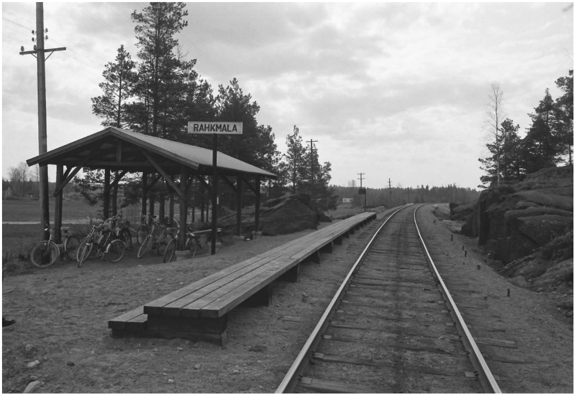
Kuva 5. Tyypillinen Uudenkaupunginradan seisake Rahkmalassa. Betonianturoille perustettu suurehko odotuskatos palvelee niin junan odottajia kuin myös polkupyörien säilytystä sääsuojassa. Kahden vaunun ovisijoittelua palveleva puinen seisakelaituri on yksinkertainen, käytännössä se on perustettu suoraan ratapenkalle ratapölkkyistä sahattujen kantavien osien päälle. Rahkmala, 29.4.1974. Kuva: Tapio Keränen.
