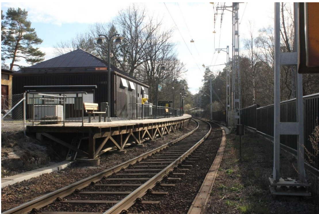
Kuva 2. Östervikin seisake Saltsjöbanan paikallisrautatiellä. Seisake sijaitsee s-mutkassa sekä osittain mäessä. Seisakkeella on kaluston lattiakorkeuden mukainen korkea puulaituri. Puulaiturin kantavat rakenteet ovat perustettu betonianturoille. Östervik, 14.4.2019. Kuva: Arne Alameri.
