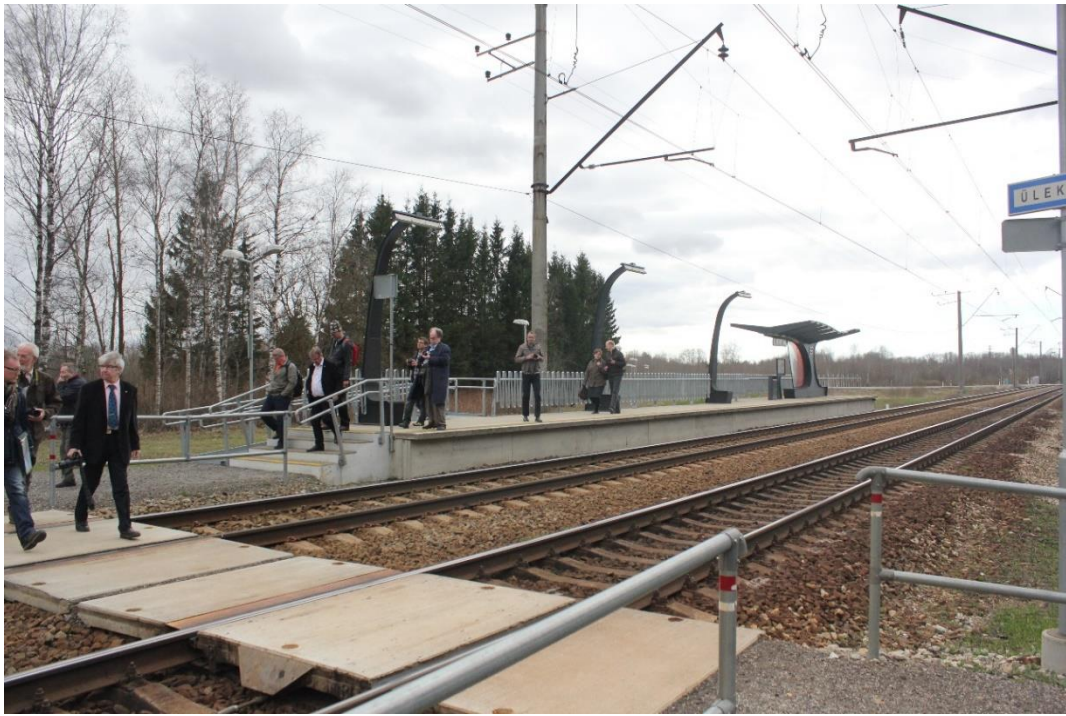
Kuva 18. Kullin seisake sijaitsee Tallinnan ja Aegviidun välisellä rataosalla. Seisakkeen uudelleenrakennuksen yhteydessä siitä tehtiin ainoastaan yhden vaunun mittainen. Junien matkustajainformaatiolla kerrotaan, mikä osa junasta palvelee lyhyitä seisakkeita, muissa vaunuissa ovet pysyvät lukittuina. Esteetön yhteys laiturille kulkee radan vastapuolelta laituripolun kautta. Kulli, 5.5.2013. Kuva: Aarne Alameri.
