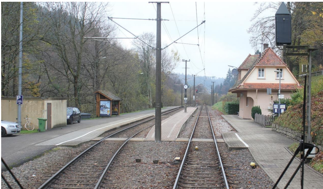
Kuva 13. Frauenalbin seisake sijaitsee Saksassa AlbtalBahnilla Ettlingenin ja Bad Herrenalbin välisellä rautatieosuudella, jonka henkilöliikenne operoidaan duoraitiovaunuin. Rataosa on voittopuolisesti yksiraiteinen ja sen liikennöinti perustuu yksisuuntavaunujen käyttöön (ohjaamo vain toisessa päässä ja ovet yhdellä sivulla, raitiovaunut käyttävät kääntösilmukoita pääteasemilla). Tästä syystä kohtauspaikoilla liikennöidään vasemmanpuoleista liikennettä, jolloin duoraitioliikenne tarvitsee ainoastaan yhden keskilaiturin. Liikennepaikan sivulaituria ei normaalitilanteissa käytetä. Frauenalb, 21.11.2013. Kuva: Aarne Alameri.
