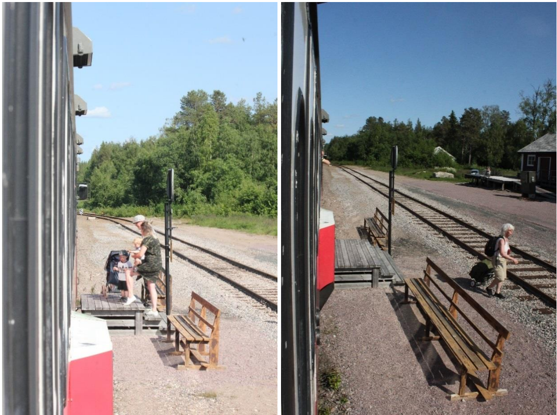
Kuva 26. Slagnäs in seisake sijaitsee Storumanin ja Arvidsjaurin välisellä rataosalla. Ratapihan raiteiden väliin sijoitettu puurakenteinen porrasaskelma on noin kahden metrin mittainen. Askelman molemmin puolin on pitkät istuimet. Slagnäs, 10.7.2019. Kuvat: Aarne Alameri.
