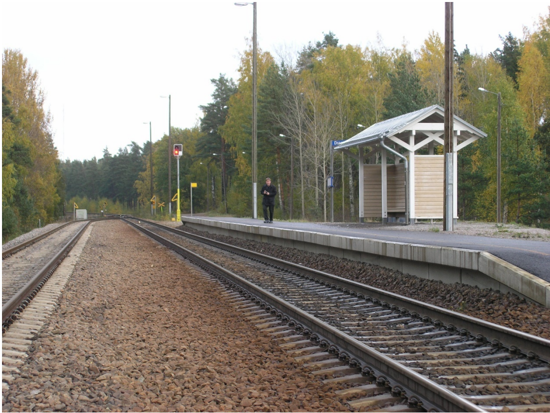
Kuva 23. Dragsvikin asfalttipintainen ja betonielementtireunainen seisakelaituri. Laiturin perusrakenne vastaa tässä työssä esitettävää mallia. Dragsvik, 7.10.2004. Kuva: Antero Alku.
