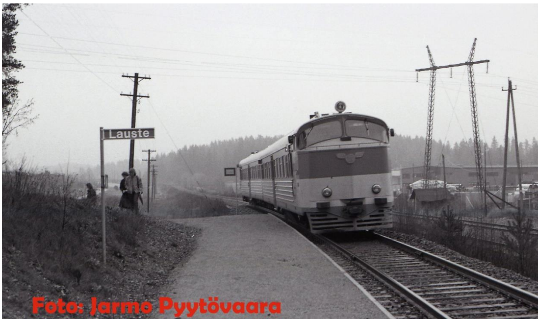
Kuva 10. Paikallisliikennekokeilun henkilöjuna H 364 on lähtenyt liikkeelle kohti Varrassuota osittain kaarteessa olevalta Lausteen seisakkeelta. Paikallisliikennekokeilua varten toteutetulla hiekkapintaisella laiturilla oli betonielementtireuna. Lauste, 13.5.1987. Kuva: Jarmo Pyytövaara.
