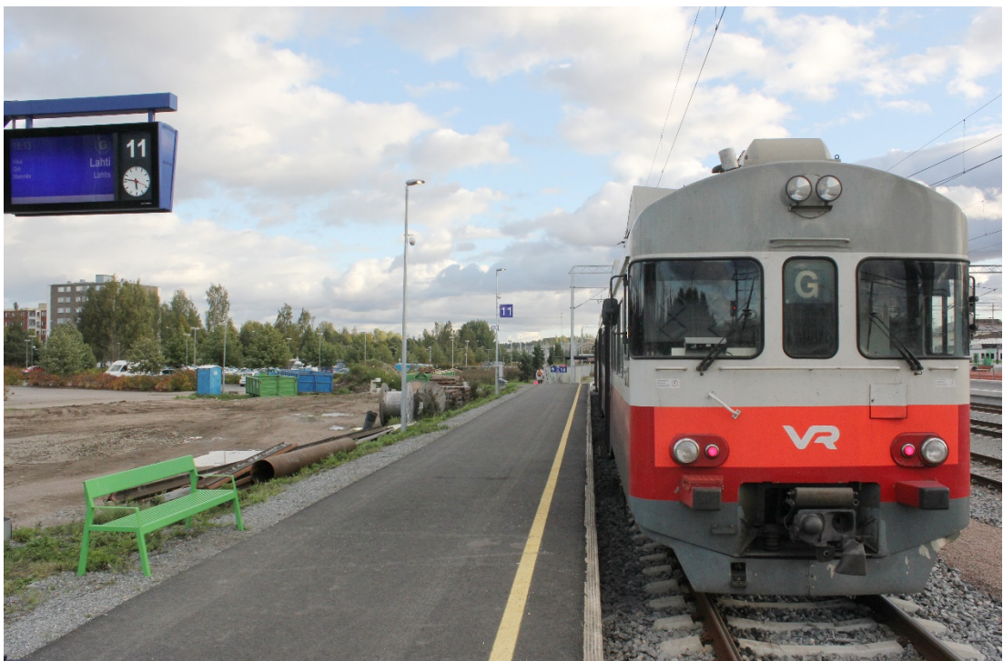
Kuva 24. Riihimäen aseman laajan remontin vuoksi rakennettu tilapäiseksi tarkoitettu raiteen 11 laiturin perusrakenne on saman kaltainen kuin tässä työssä esitettävien laitureiden perusratkaisu. Riihimäki 19.9.2020. Kuva: Aarne Alameri.
