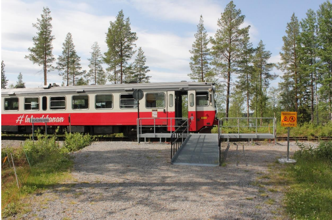
Kuva 22. Vilhelmina Norran seisake sijaitsee Ruotsissa Inlandsbanalla Hotingin ja Storumanin välisellä rataosalla. Ritiärakenteinen laiturilla on periaatteiltaan vastaava kuin Åsarna Södralla, paitsi esteetön ramppi laiturille on päädyn sijaan keskempänä laituria. Laiturilla ei ole varsinaista odotuskatosta, sillä seisakkeen läheisyydessä sijaitsee huoltoasema.
