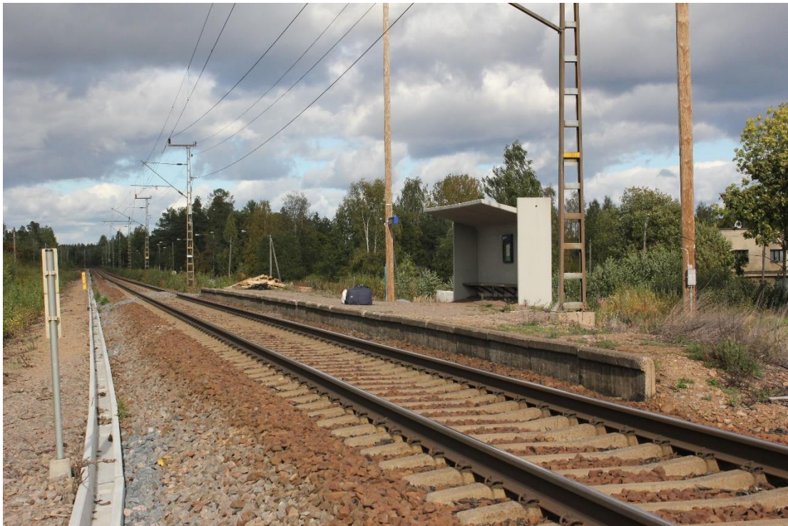
Kuva 10. Tavastilan seisake. Seisake edustaa paikallisliikenteen perinteistä seisaketta. Seisake on va-laistu ja sillä on sadekatos sekä roskakori. Seisakkeelle ei ole tehty mainittavia parantamistoimia vuosikymmeniin. Laiturin pituus on 53 m. Tavastila, 19.9.2020. Kuva: Aarne Alameri.
